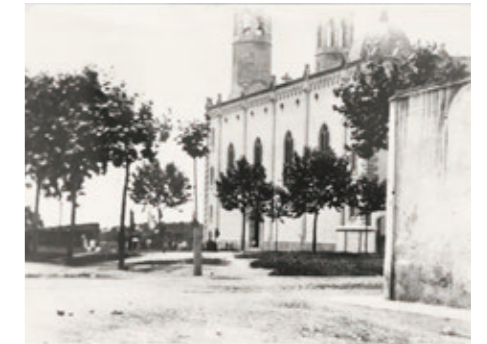
Entrada d'una processó per la porta lateral de l'església abans de la construcció del Centre Parroquial, vers 1915. (AMSPR. Fons d'imatges. Autor desconegut)
